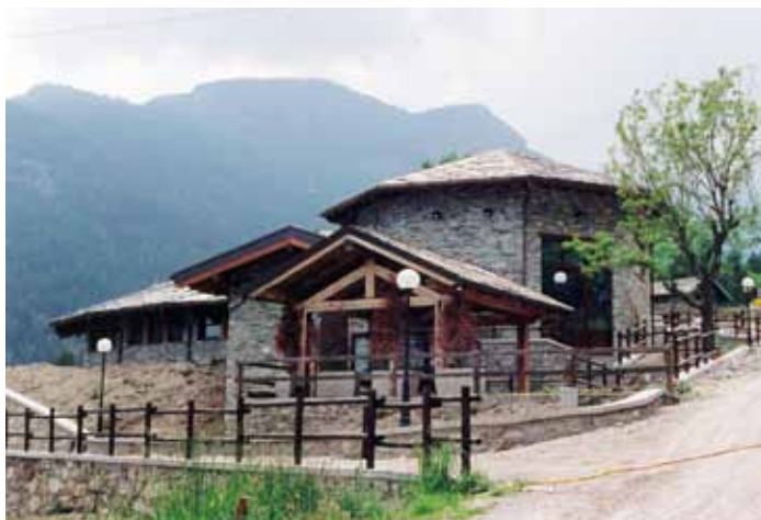
Esterno del centro visita.
